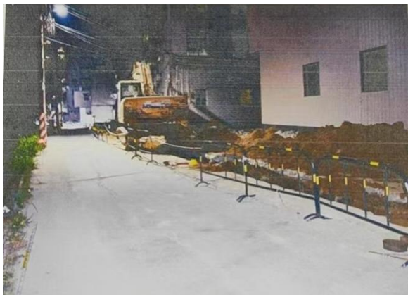
图 1 现场道路情况
