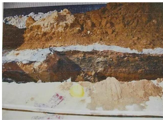
图 2 现场沟槽情况
