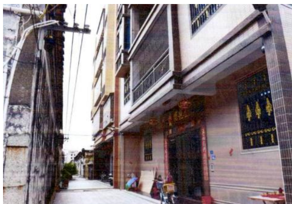
图 1 现场楼房照片
