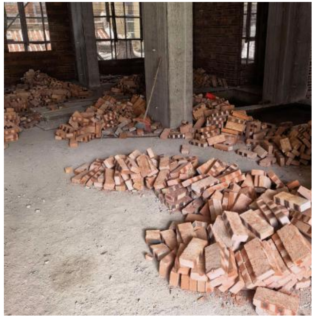
图 2 现场二层情况
