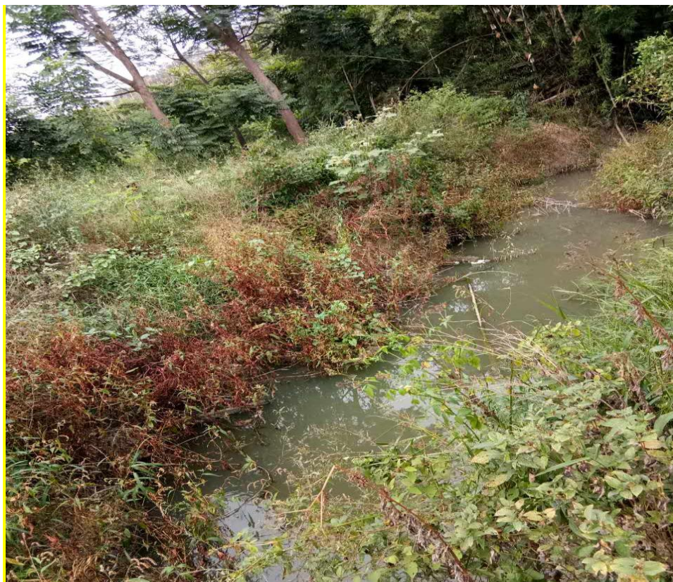
图 2-2 夏地分干渠现状照片
