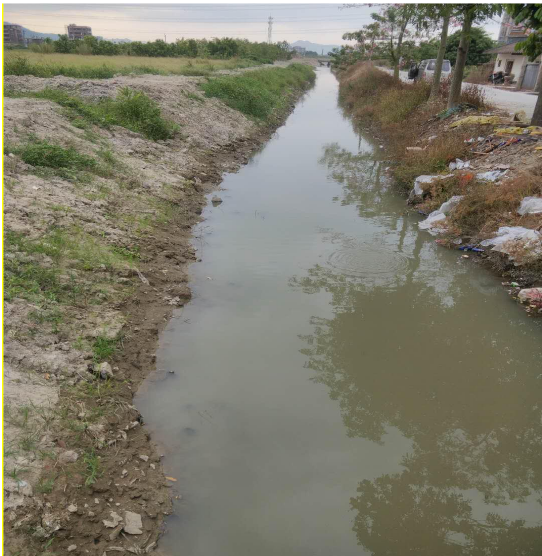
图 2.2-1 南干渠现状照片
