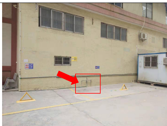
生活污水接入口
