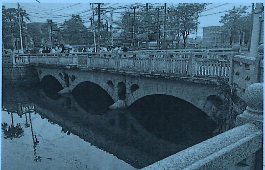
1. 现状桥面两侧钢筋混凝土栏杆(1.2M高)以及道路两侧两根铁管拆除照片:
