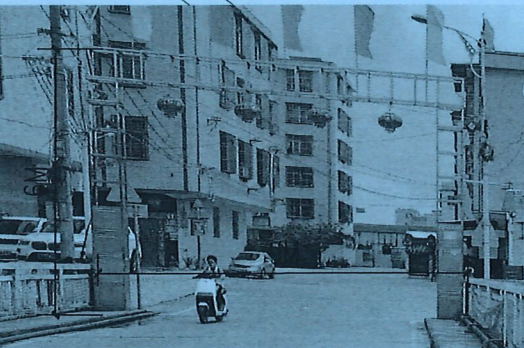
2. 拆除现状桥头限高门架: 高6M, 长9M, 宽0.4M; 整体框架是不锈钢方通搭建。
