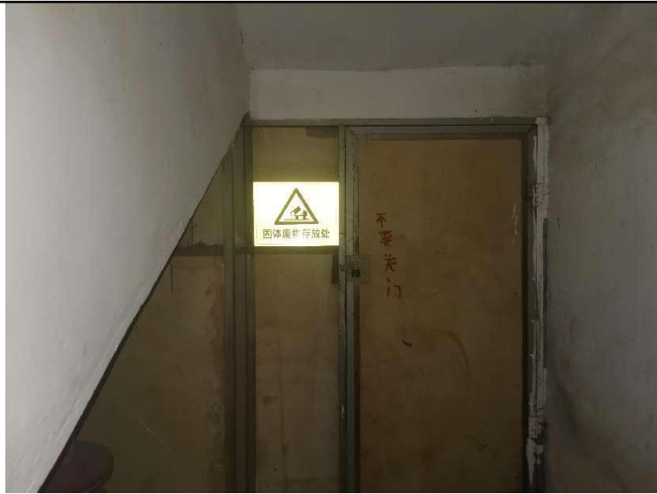
固废暂存间 图2-8 污染治理设施照片
