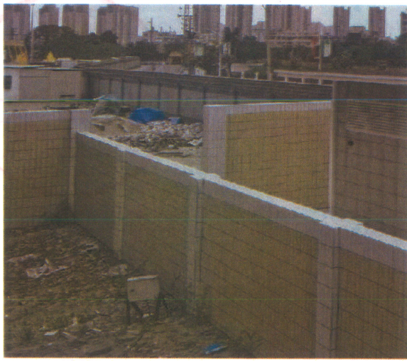
项目北面为利泰制药办公楼、污水处理站
