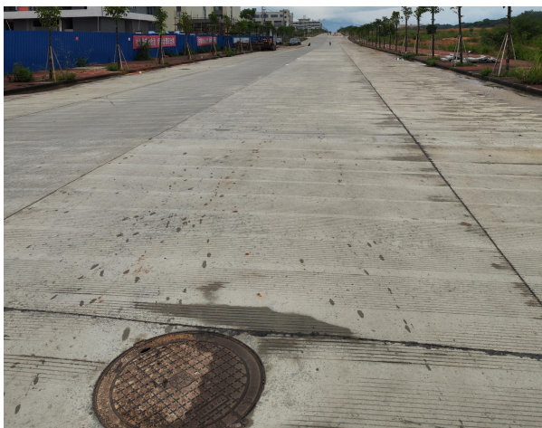
项目西面现状图（康泰路）
