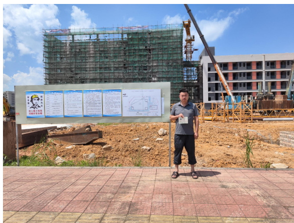
工程师现场踏勘记录
