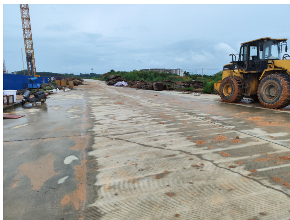
项目北面现状图（水厂南路）
