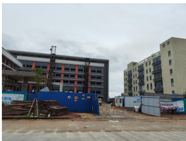
项目南面现状图（吉明丰厂房）
